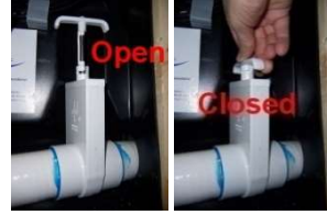
Figure 15 – Robinet ouvert/fermé
